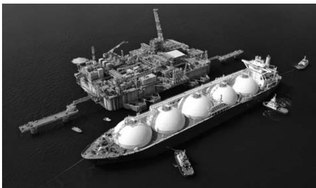
Arrivo della prima nave di GNL al Terminale GNL Adriatico
