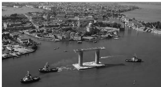
Le strutture di ormeggio vengono rimorchiate da Venezia al Terminale GNL Adriatico
